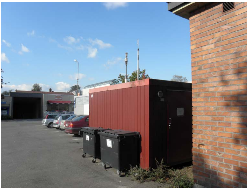
Kuva 9. Heinolan Keskustan Torikadun ilmanlaadun mittausasema.
