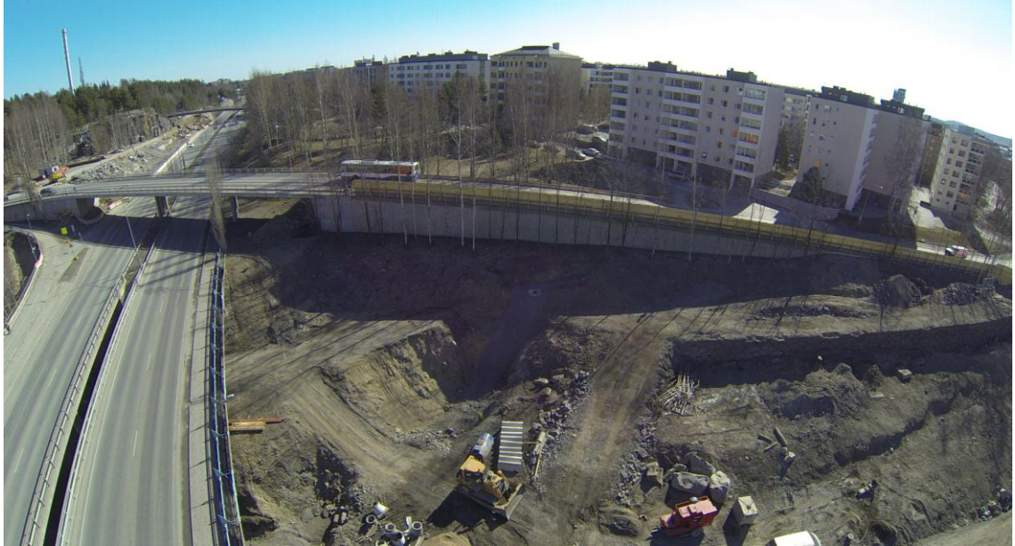
Kuva 3.3. Tunnelityömaa Naistenlahden mittausaseman länsipuolella maaliskuussa 2014. Mittausasema sijaitsee kuvan yläreunassa näkyvässä puistossa. Kuva: Rantatunnelin allianssi.
