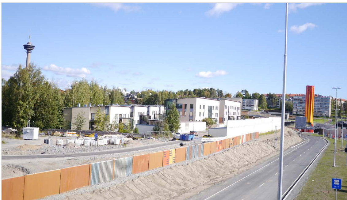
Kuva 7. Santalahden ilmanlaadun mittausasema (kuvan vasemmassa laidassa) syyskuussa 2016, jolloin meluaita on jo valmistunut. Tunnelin suuaukot sijaitsevat puna-keltaisen ilmanvaihtopiipun vieressä, sen kummallakin puolella. Kuva: Emmi Laukkanen, Ilmatieteen laitos.
