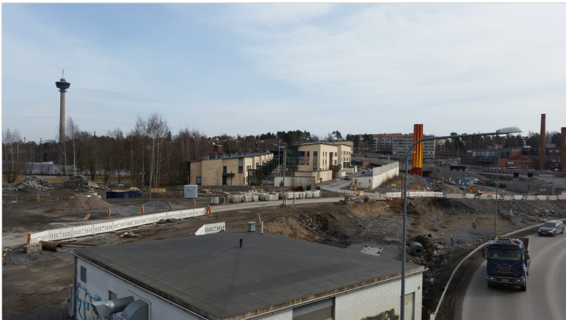
Kuva 6. Santalahden ilmanlaadun mittausasema kuvan keskellä olevan rakennusrivistön päässä, huhtikuussa 2016. Kuva: Kaj Lindgren, Ilmatieteen laitos.
