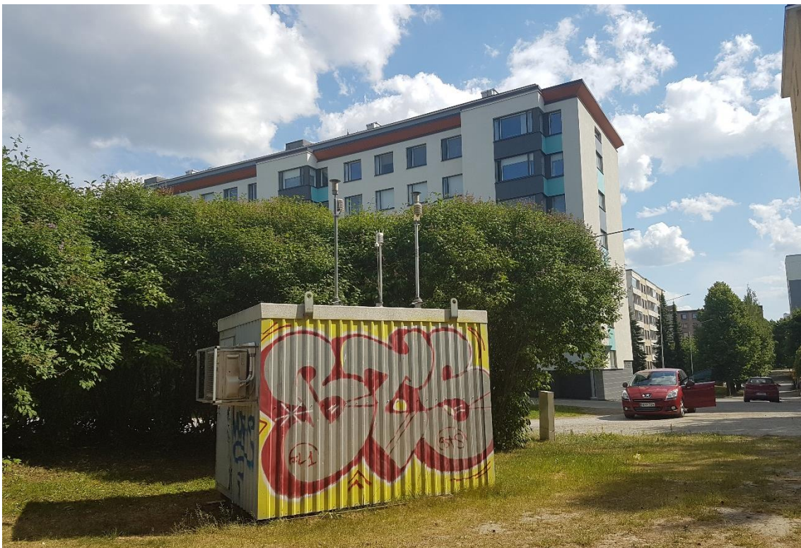
Kuva 32. Naistenlahden ilmanlaadun mittausasema Tunturipuistossa, kesäkuussa 2018. Ulkoilma imetään mittauslaitteisiin mittausaseman katolla sijaitsevien näytteenottosondien kautta. Kuva: Jatta Salmi.
