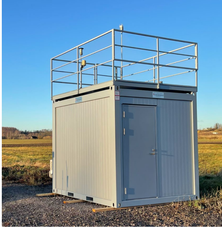
Kuva 13. Ilmanlaadun mittausasema Lappeenranta Ojala-Tuomela. Ulkoilma imetään mittalaitteisiin kontin katolla sijaitsevien näytteenottimien läpi. Lisäksi katolla on säämittausanturi. Valokuva: Antti Mannisenaho.
