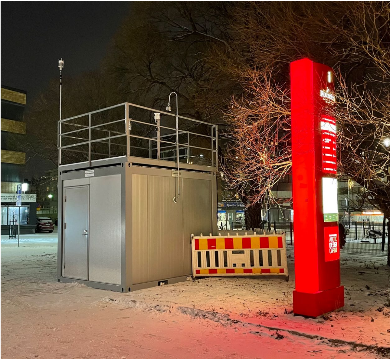
Kuva 21. Ilmanlaadun mittausasema Rovaniemi Rovakatu. Ulkoilma imetään mittalaitteisiin kontin katolla sijaitsevien näytteenottimien läpi. Lisäksi katolla on säämittausanturi. Valokuva: Antti Mannisenaho.
